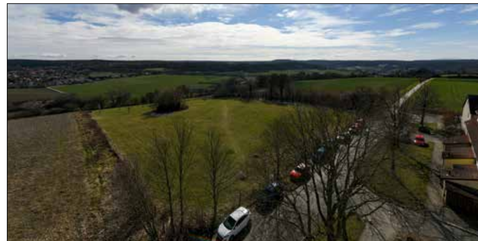
Blick nach Südosten auf Roringen und Herberhausen
