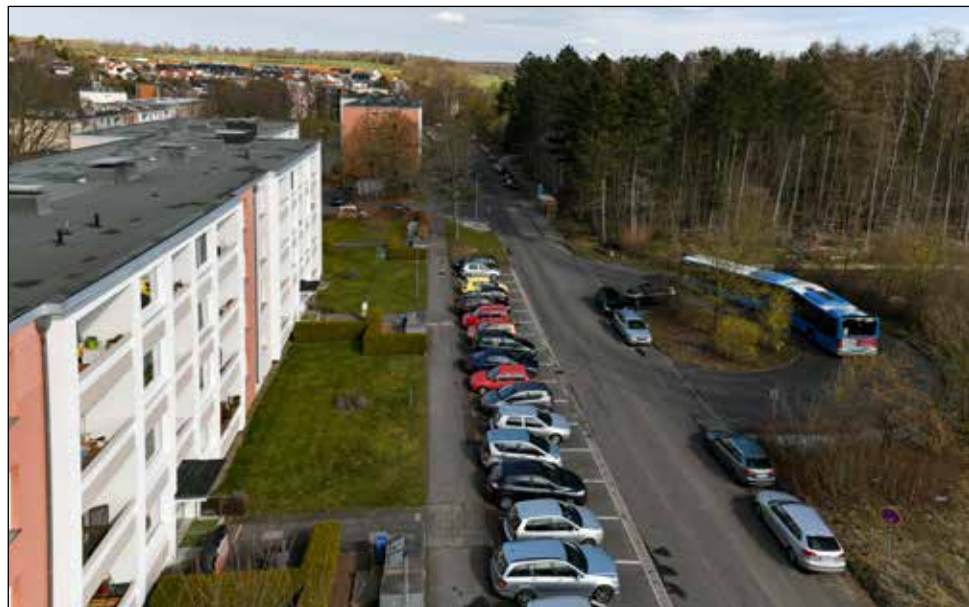
Blick auf die Strasse „Auf der Lieth“
