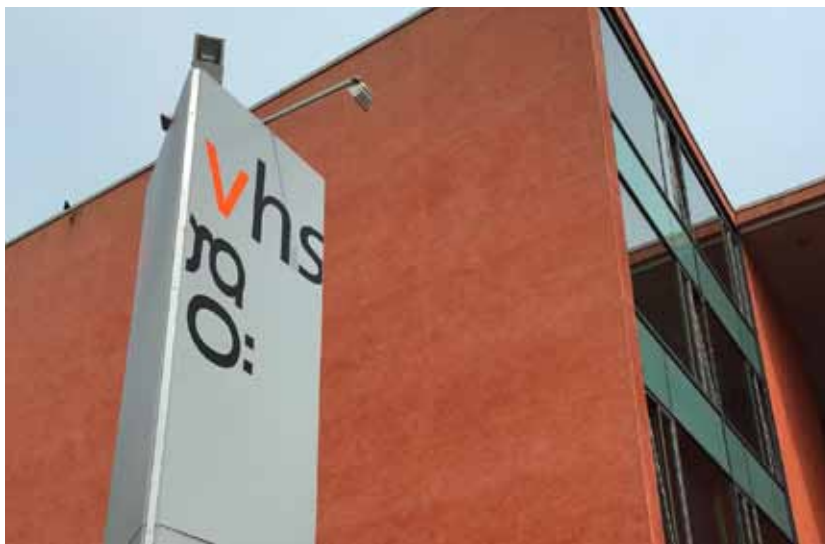
Unterrichts- und Verwaltungsgebäude für die Volkshochschule Göttingen
